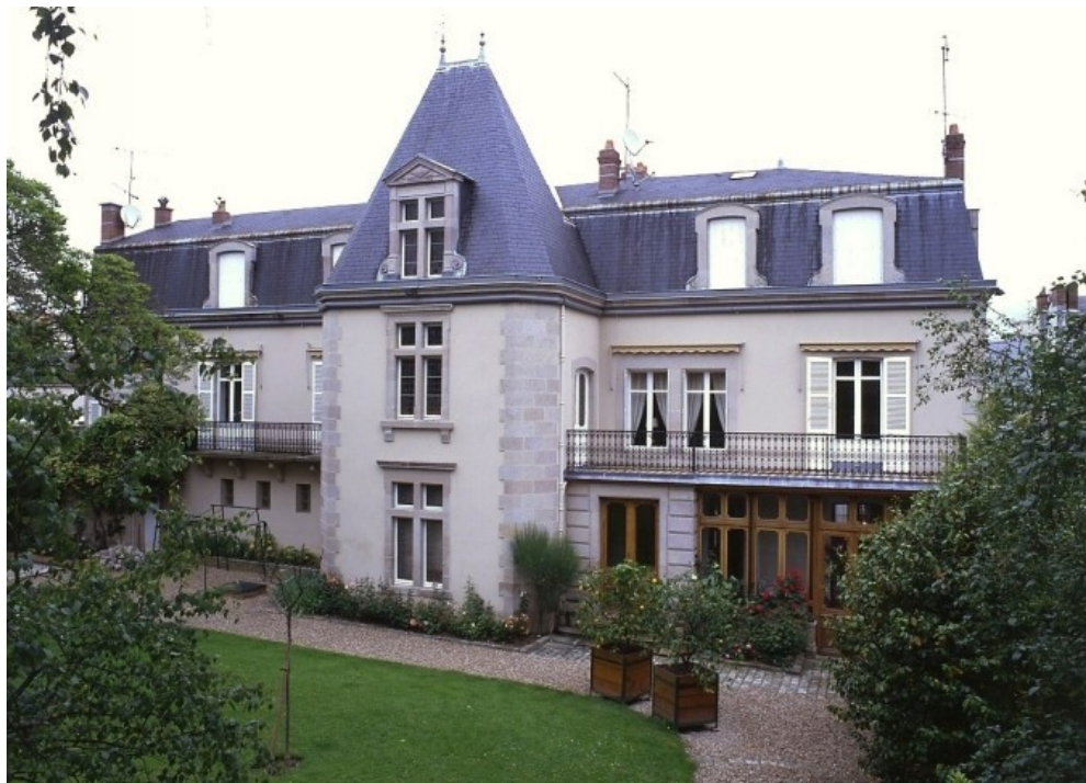
Immeuble Lacaux, impasse Saint-Exupéry, protégé par la ZPPAUP et condamné à la démolition par un permis de construire (photo inventaire du patrimoine industriel Pillet)
